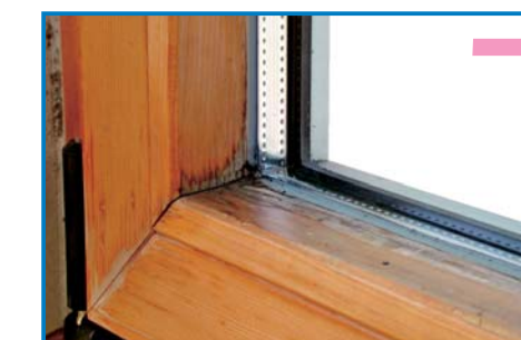
NEGATIV: TYPISCHE SCHIMMELBILDUNG AUF DER SILICON-SCHICHT BEI DER NASSVERGLASUNG
