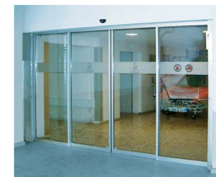
Automatische Rauch- und Brandschutz-Schiebetüren erleichtern die berührungslose Passage im Alltag. Im Notfall hemmen sie die Ausbreitung von Rauch und Feuer.
